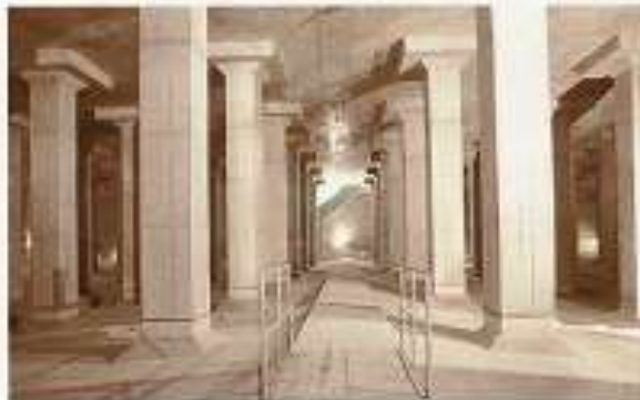
調整池 雨水を一時貯留します。
