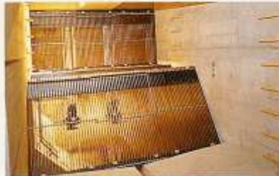
スクリーン 雨水の中に含まれている大きなゴミなどを取り除きます。
