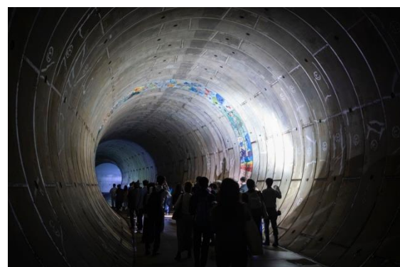
トンネル内視察
