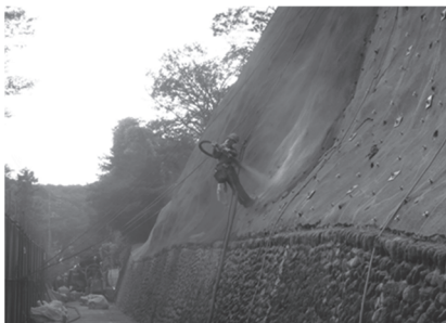
モルタル吹付工
