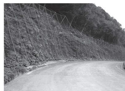
落石防護網工
