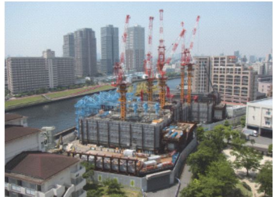
雨水ポンプ所（建設中） 《千住関屋ポンプ所》
