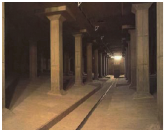
完成した雨水調整池 《南元町雨水調整池》
