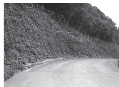
落石防護網工
