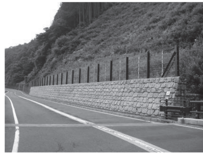
落石防護柵工
