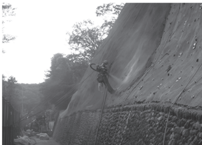
モルタル吹付工
