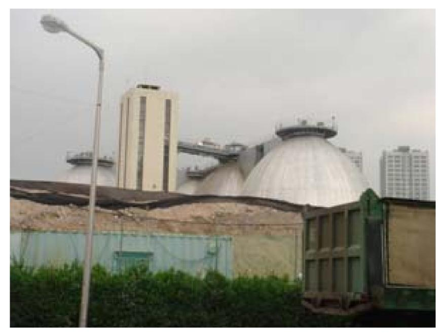
11/19 AM ごみ、下水汚泥からメタンガスを回収する資源化施設(韓国プサン市)
