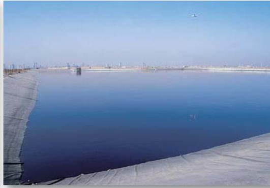
調整池では、浸出水の流量調節や水質の均一化を図り、排水処理場に送水しています。
