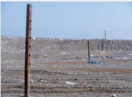
埋め立てた廃棄物からメタンガスが発生します。このガスによる火災が起こらないよう、パイプを打ち込んで、ガスを抜いています。
