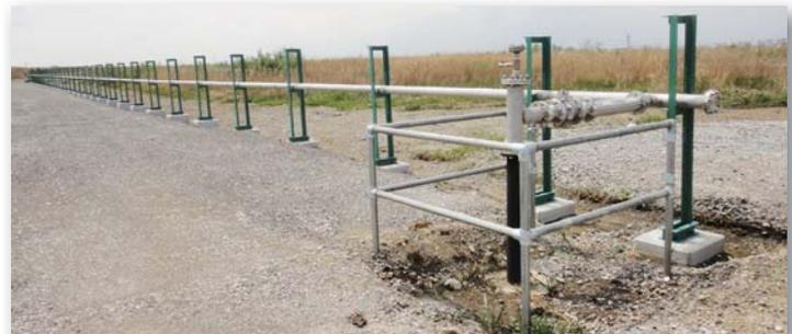
発生ガスを採取、貯留し、ガスタービンで燃焼させ、発電を行っています。
