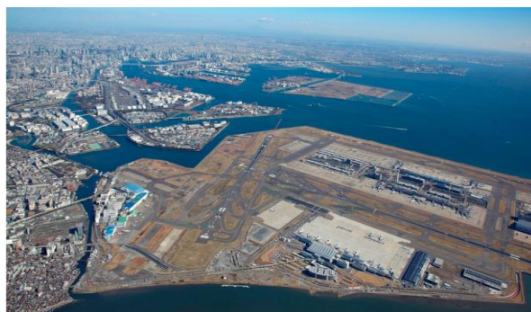
羽田空港周辺地域
