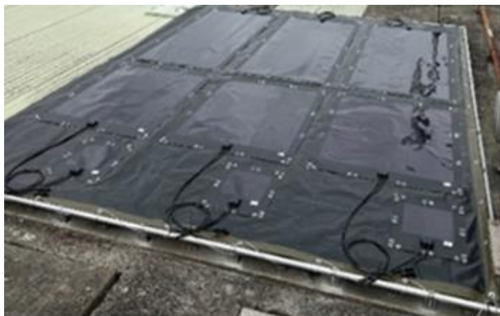
国内初となる下水道施設における 次世代型ソーラーセルの実用化に向けた検証（森ヶ崎水再生センター）
