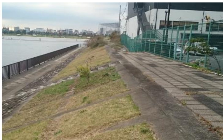
嵩上げを実施する防潮堤（港南地区）
