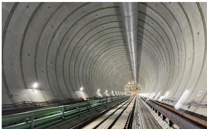
事業中の環状七号線地下広域調節池（石神井川区間）
