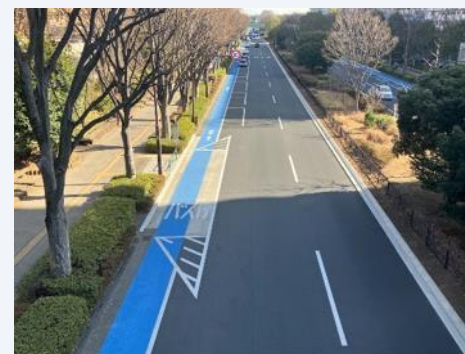
自転車専用レーン（南田中町旭町線：練馬区）
