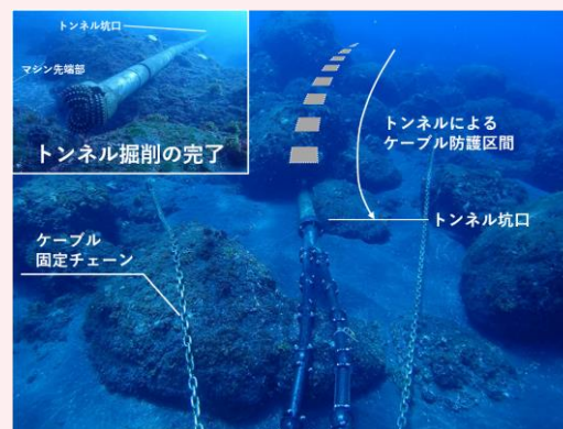
御蔵島における海底光ケーブルの強靱化対策工事
