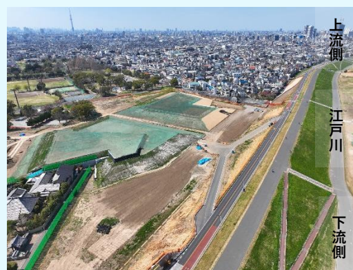
盛土工事中の高規格堤防(江戸川区篠崎地区)
