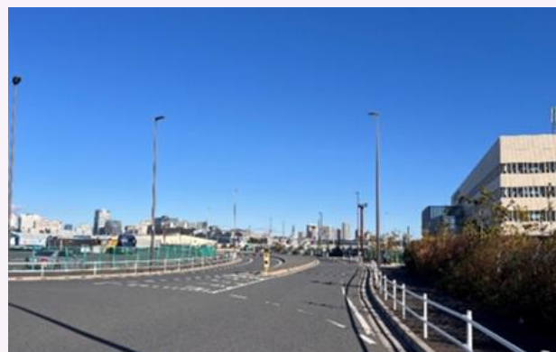
有明ふ頭連絡線（江東区有明4丁目）
