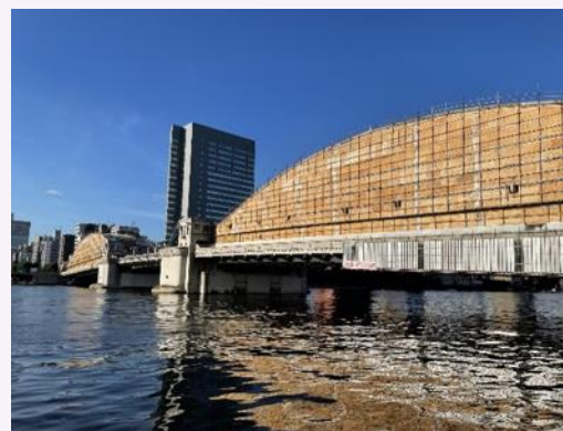
橋梁の長寿命化工事（塗替塗装）の状況（勝鬨橋）
