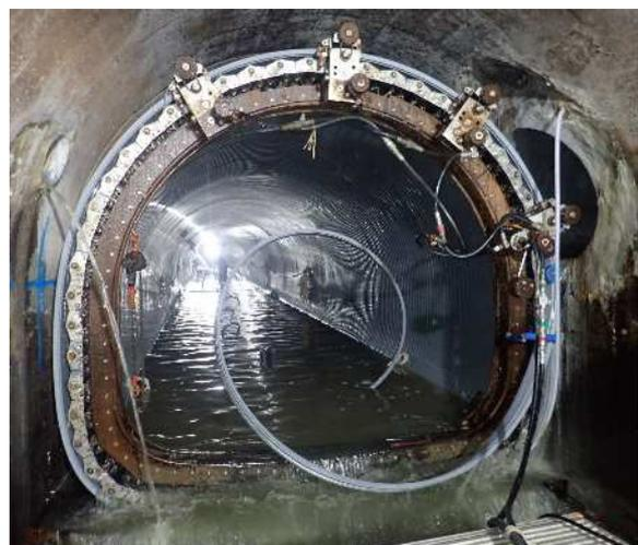
更生工法による幹線再構築
