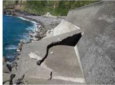
老朽化による施設の破損状況 (左)御蔵島、(右)三宅島
