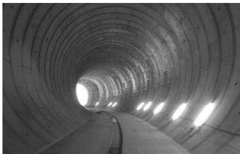
白子川地下調節池(整備中)
