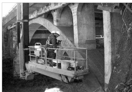
橋梁点検車による定期点検
