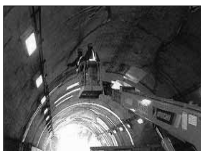
トンネル点検
