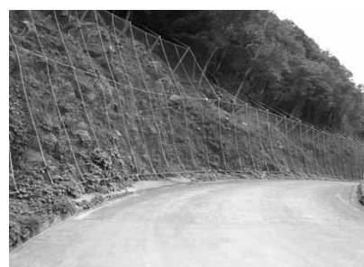
落石防護網工
