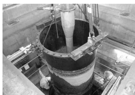
排水機場点検
