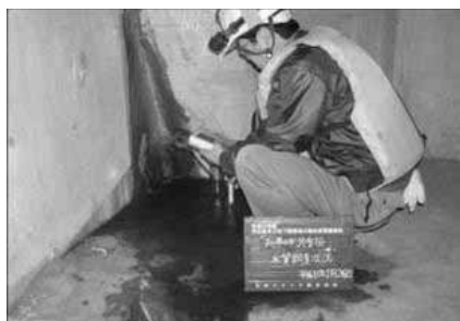
土木躯体点検
