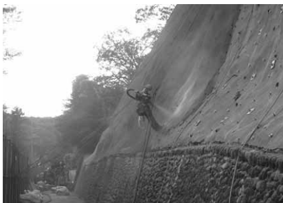
モルタル吹付工
