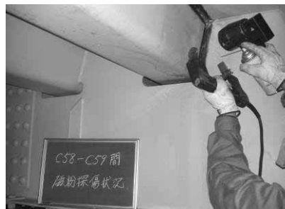
詳細健全度調査
