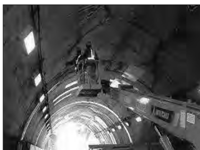
トンネル点検
