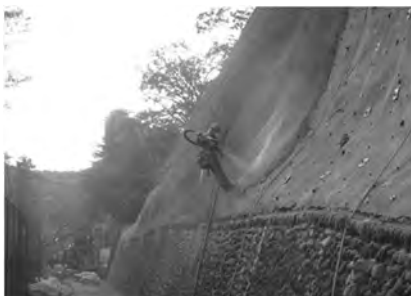
モルタル吹付工
