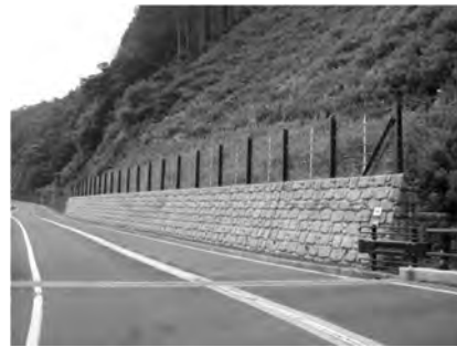
落石防護柵工
