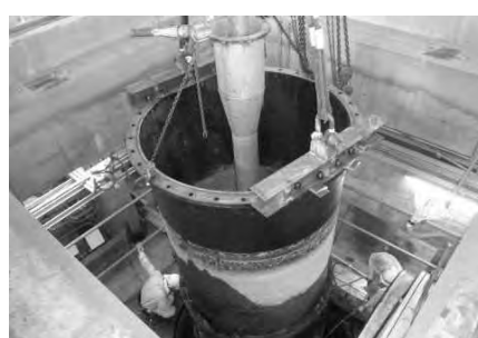
排水機場点検
