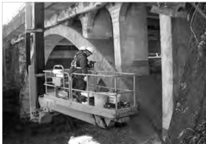
橋梁点検車による定期点検
