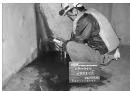
土木躯体点検
