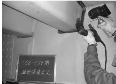
詳細健全度調査
