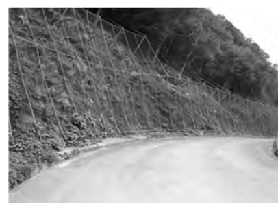
落石防護網工
