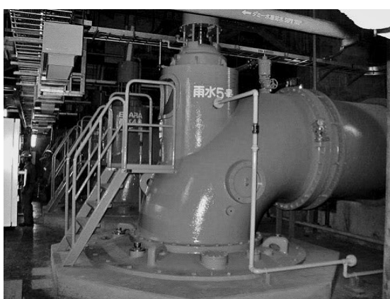
雨水排水ポンプの増強 《先行待機型ポンプ》
