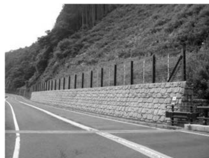
落石防護柵工
