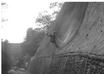
モルタル吹付工
