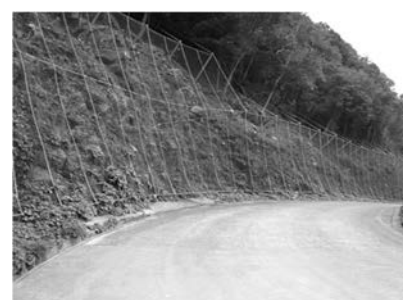
落石防護網工
