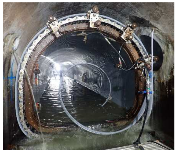
更生工法による幹線再構築
