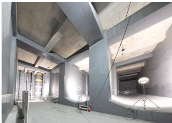
完成した雨水貯留施設 《渋谷駅東口（4,000 m 3 ）》
