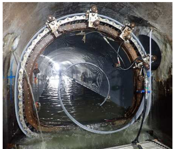
更生工法による幹線再構築
