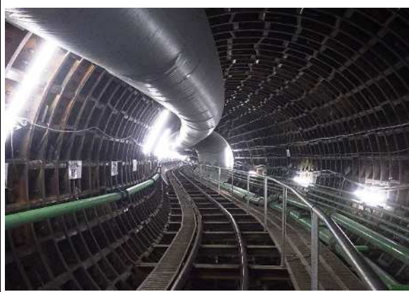
浸水対策幹線の整備 《千川増強幹線》
