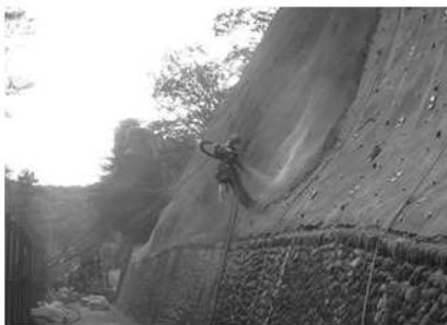
モルタル吹付工
