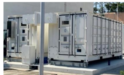
大型蓄電池再構築
