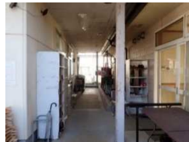
玄関付近（現状） 増築に伴い動線が分断
