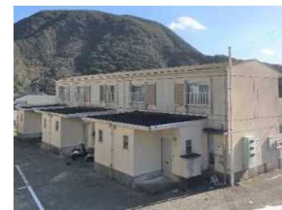
改修予定の公営住宅
