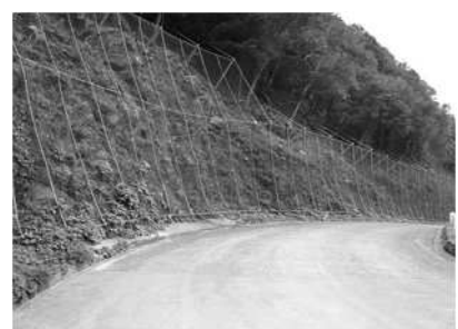
落石防護網工
