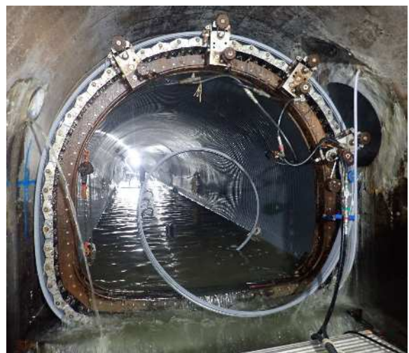
更生工法による幹線再構築
