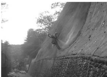
モルタル吹付工
