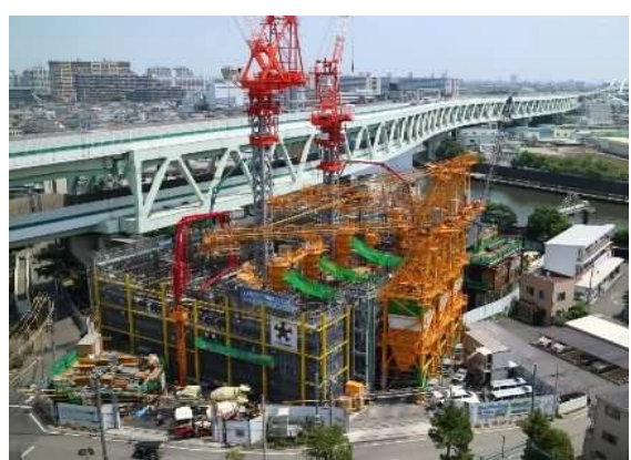
雨水ポンプ所の整備 《王子第二ポンプ所》
