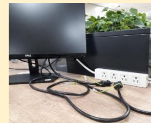
コンセント抜線の徹底
