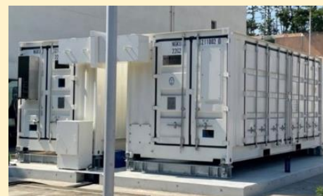
大型蓄電池再構築
