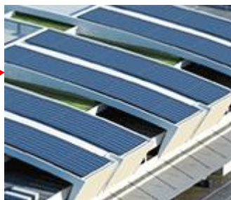
＜屋上のソーラーパネル＞
