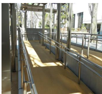
<施設出入口のスロープ改修工事>
