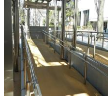
＜施設出入口のスロープ改修工事＞
