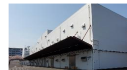
多摩広域防災倉庫
