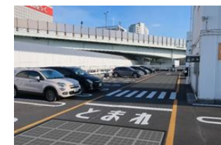
舗装式太陽光パネル
