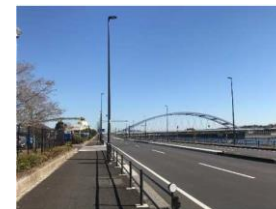
臨港道路の無電柱化状況（海の森地区）
