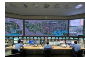
交通管制センター
