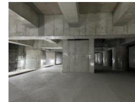
整備中の千住関屋ポンプ所
