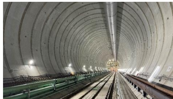
環状七号線地下広域調節池（石神井川区間）（整備中）
