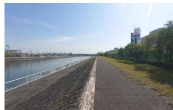
嵩上げを実施する防潮堤（港南地区）
