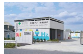
京浜島グリーン水素製造所
