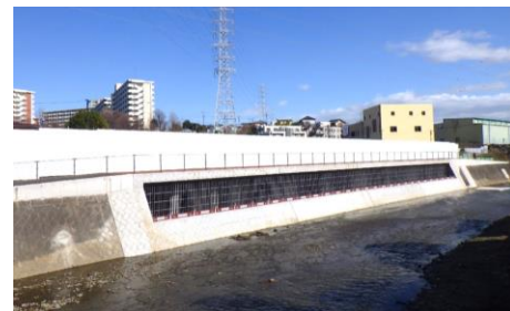
稼働開始した境川木曽東調節池
