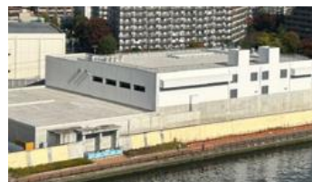
稼働開始した千住関屋ポンプ所
