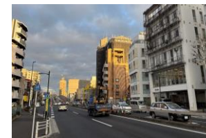
第一次緊急輸送道路の無電柱化状況 (環七通り(北区))
