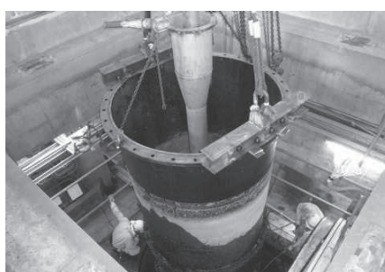
排水機場点検
