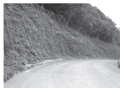
落石防護網工
