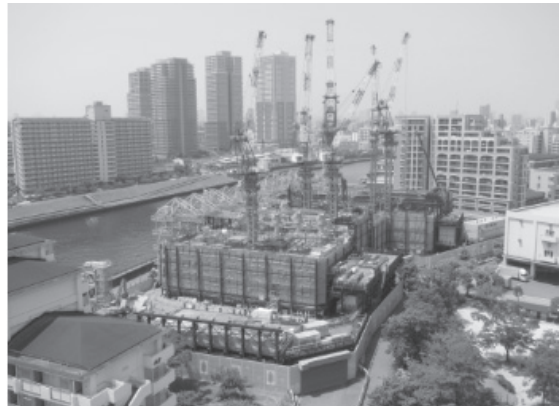
雨水ポンプ所（建設中） 《千住関屋ポンプ所》
