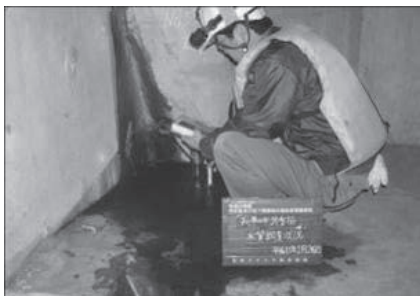
土木躯体点検
