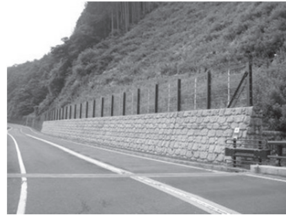
落石防護柵工
