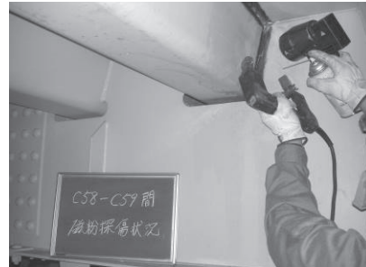
詳細健全度調査
