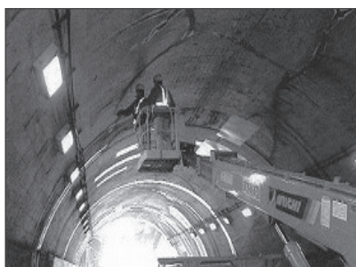
トンネル点検
