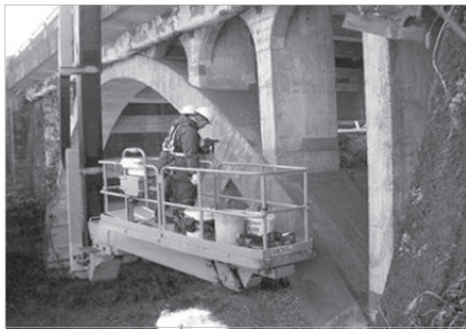
橋梁点検車による定期点検
