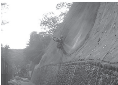
モルタル吹付工
