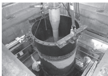
排水機場点検
