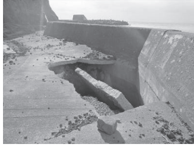
老朽化による施設の破損状況（左）御蔵島・御蔵海岸、（右）三宅島・阿古海岸
