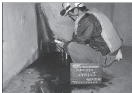
土木躯体点検
