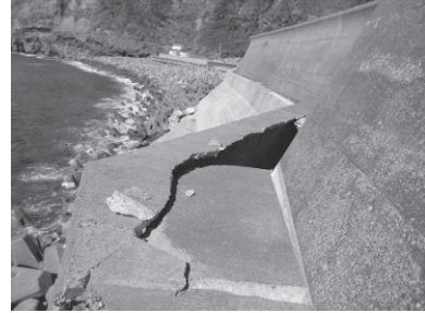
老朽化による施設の破損状況（左）御蔵島・御蔵海岸、（右）三宅島・阿古海岸
