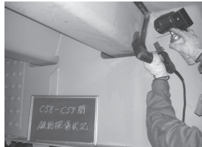
詳細健全度調査
