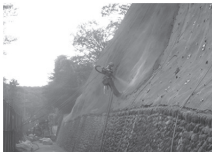
モルタル吹付工
