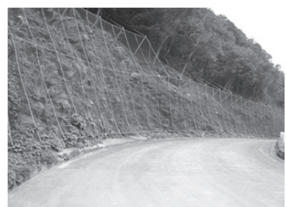
落石防護網工
