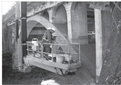
橋梁点検車による定期点検
