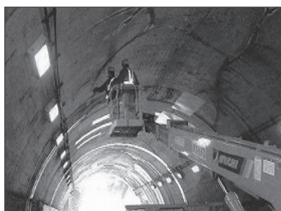
トンネル点検
