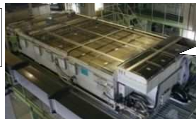
省エネルギー型汚泥濃縮機
