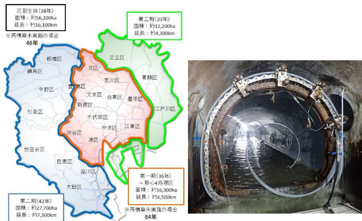
更生工法による幹線再構築
