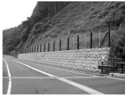
落石防護柵工
