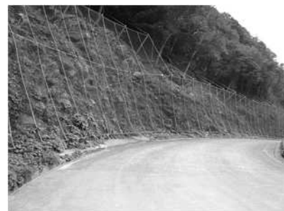
落石防止網工
