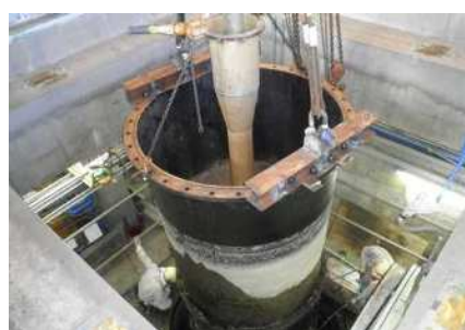
排水機場点検
