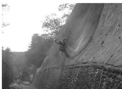
モルタル吹付工
