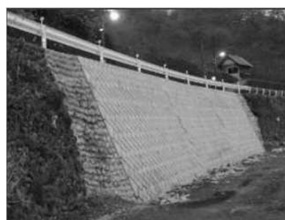
擁壁補強工（道路流失対策）
