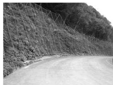
落石防止網工
