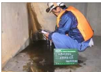
土木躯体点検
