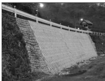
擁壁補強工（道路流失対策）
