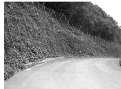
落石防止網工
