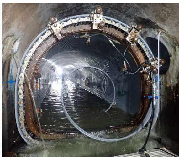
更生工法による幹線再構築
