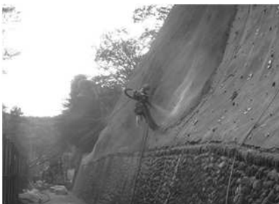
モルタル吹付工
