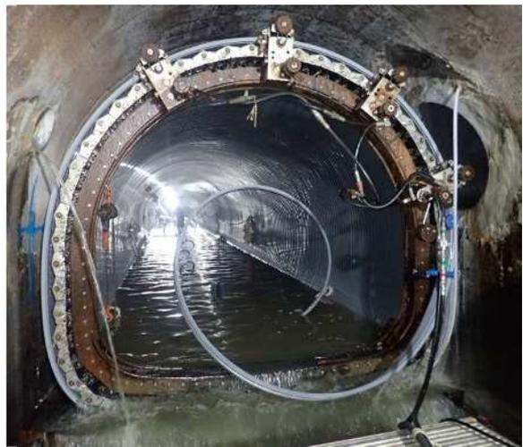
更生工法による幹線再構築
