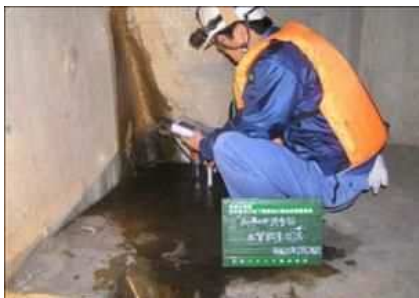
土木躯体点検
