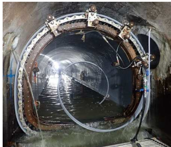
更生工法による幹線再構築
