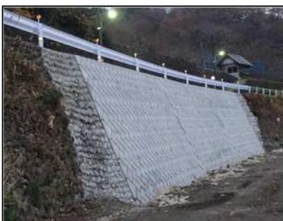
擁壁補強工（道路流失対策）
