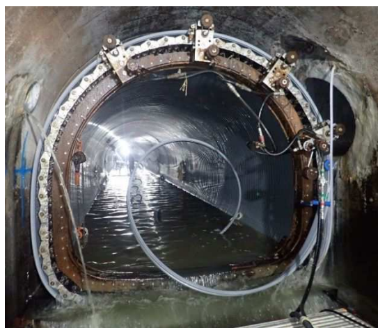
老朽化した下水道管の再構築
