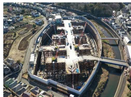
境川金森調節池整備状況
