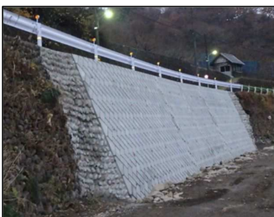
擁壁補強工（道路流失対策）
