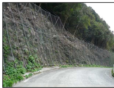
落石防止網工
