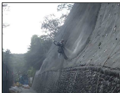
モルタル吹付工
