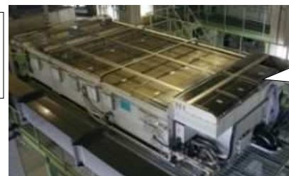
省エネルギー型汚泥濃縮機
