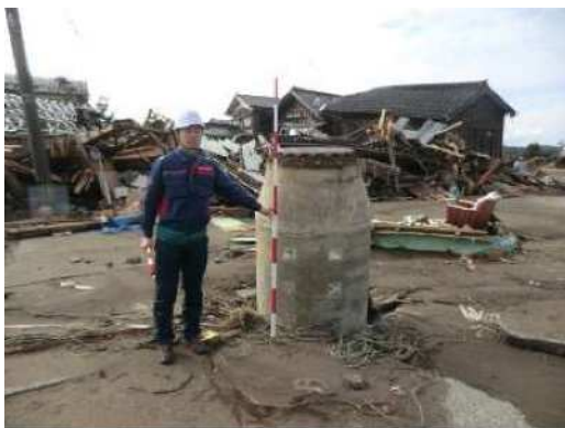
液状化による浮上（珠洲市）
