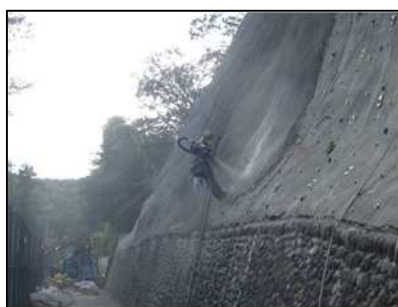
モルタル吹付工
