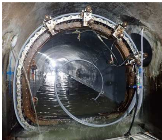
老朽化した下水道管の再構築
