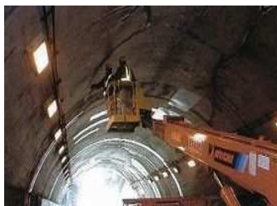
トンネル点検
