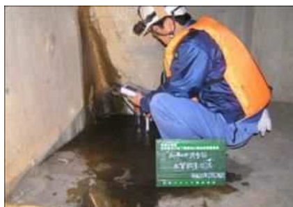
土木躯体点検
