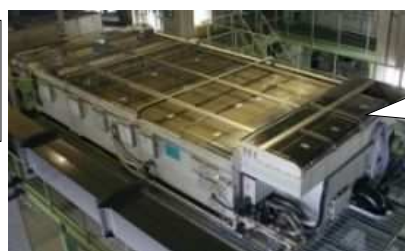
省エネルギー型汚泥濃縮機
