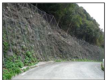
落石防止網工
