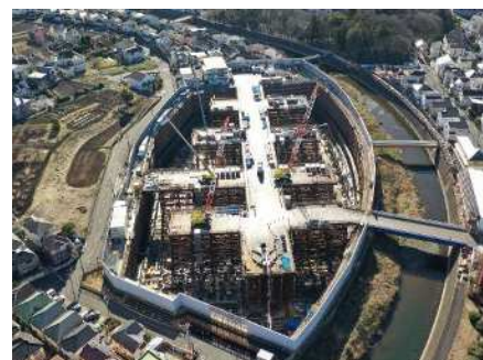
境川金森調節池整備状況
