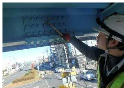
横断歩道橋点検
