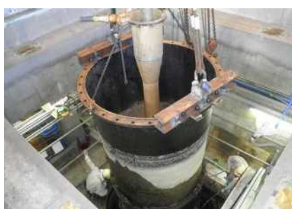
排水機場点検
