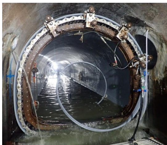
老朽化した下水道管の再構築
