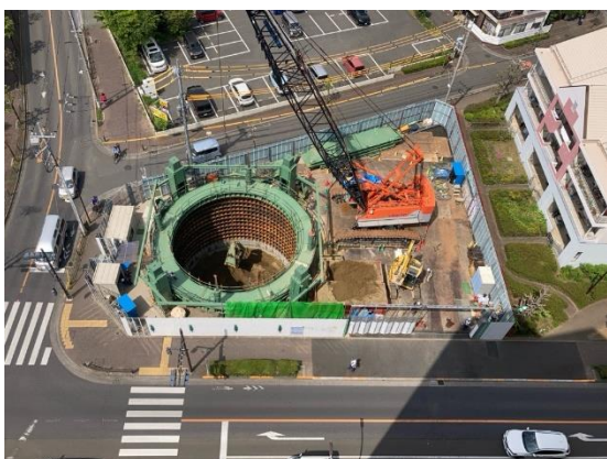
流域下水道雨水幹線の整備《空堀川上 流雨水幹線（立坑築造工）》
