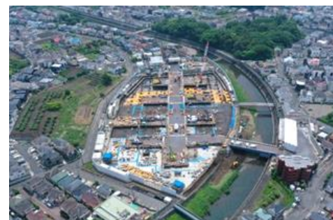
境川金森調節池整備状況
