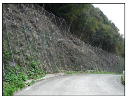
落石防止網工
