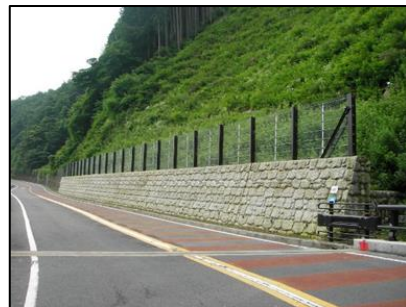
落石防護柵工
