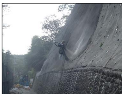
モルタル吹付工
