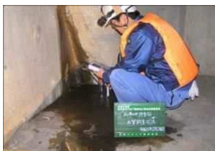
土木躯体点検
