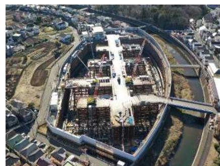
境川金森調節池整備状況
