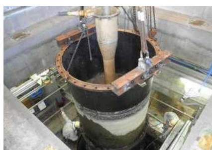
排水機場点検
