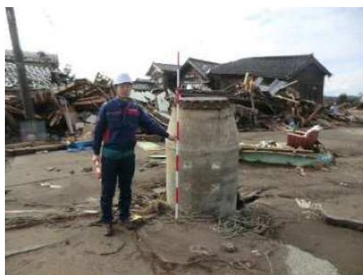
液状化による浮上（珠洲市）
