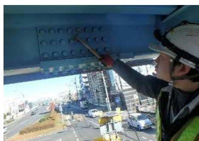
横断歩道橋点検
