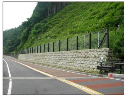
落石防護柵工
