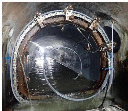
老朽化した下水道管の再構築
