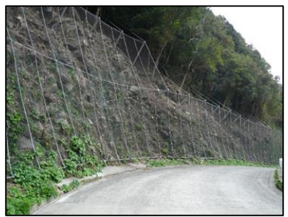
落石防止網工
