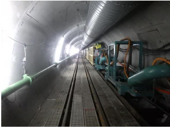
浸水対策幹線の整備 《呑川増強幹線》
