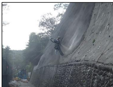
モルタル吹付工
