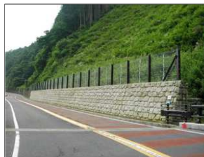
落石防護柵工
