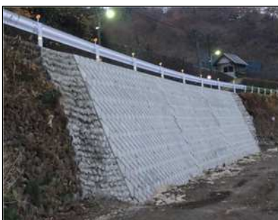
擁壁補強工（道路流失対策）
