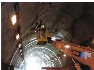
トンネル点検
