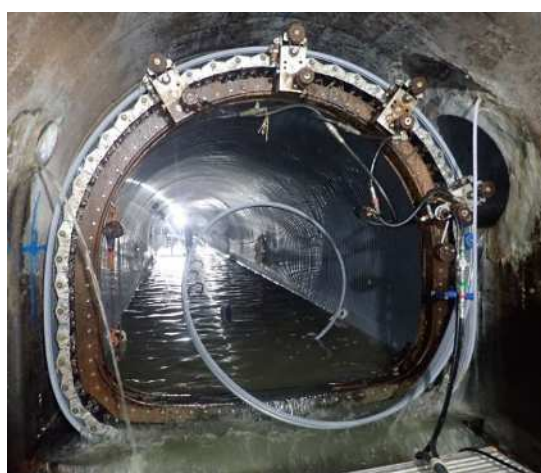
老朽化した下水道管の再構築
