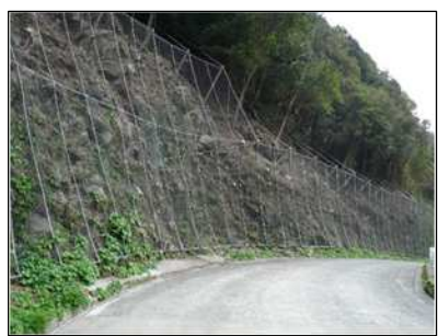
落石防止網工
