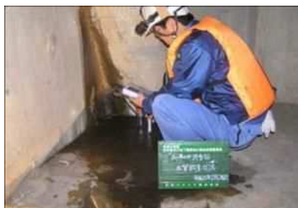
土木躯体点検
