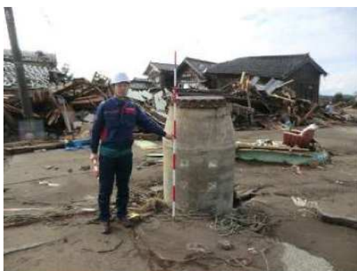
液状化による浮上（珠洲市）
