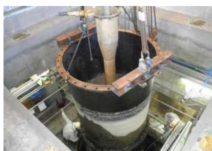
排水機場点検
