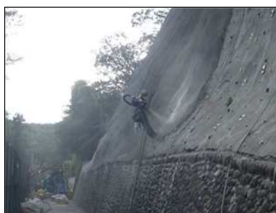
モルタル吹付工
