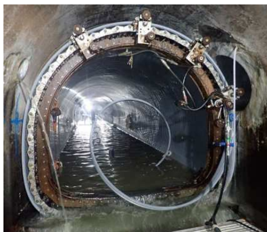
老朽化した下水道管の再構築
