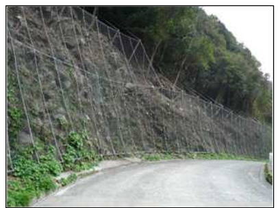
落石防止網工
