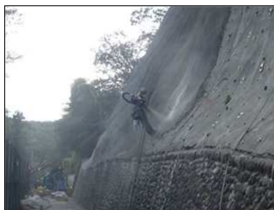
モルタル吹付工
