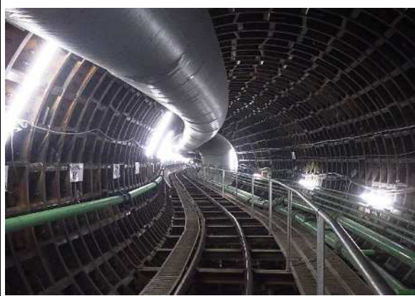
浸水対策幹線の整備 《千川増強幹線》
