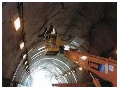
トンネル点検
