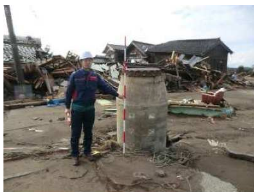
液状化による浮上（珠洲市）
