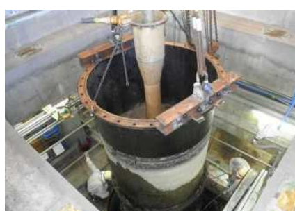
排水機場点検
