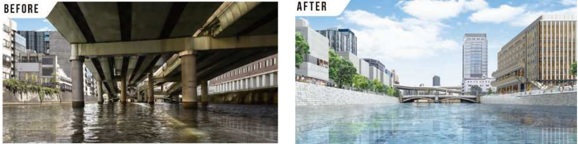
首都高速道路（株）HP より
