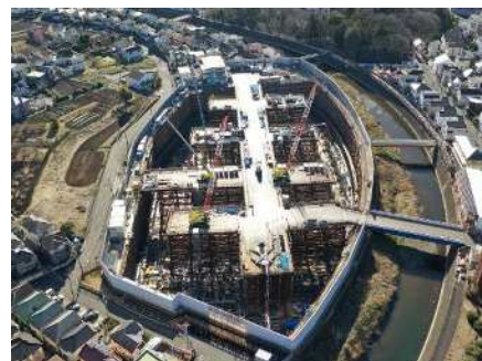
境川金森調節池整備状況
