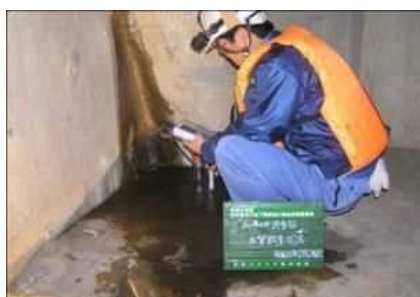
土木躯体点検
