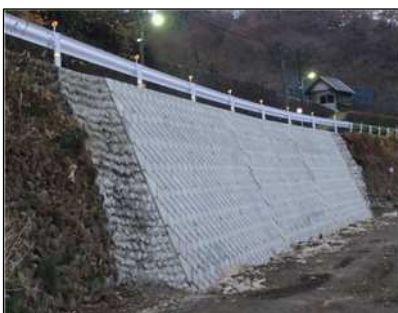
擁壁補強工（道路流失対策）
