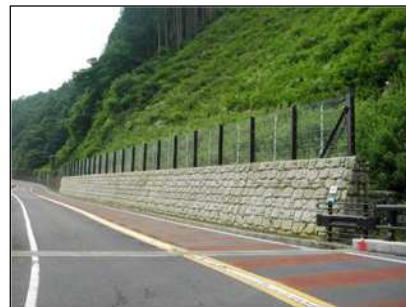
落石防護柵工
