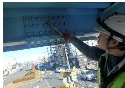
横断歩道橋点検
