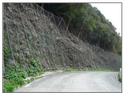
落石防止網工
