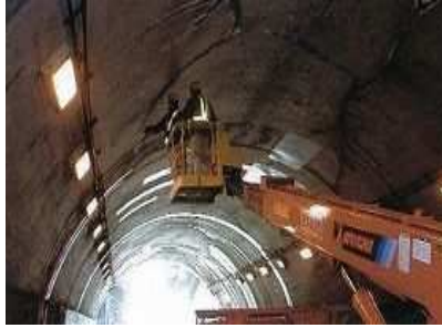
トンネル点検
