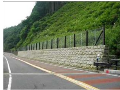
落石防護柵工
