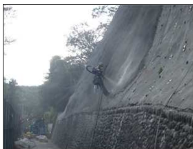
モルタル吹付工
