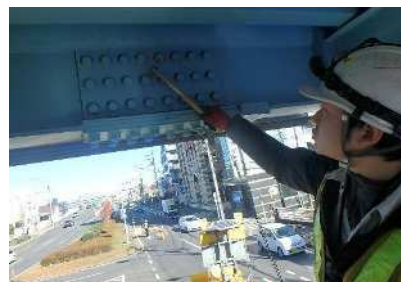
横断歩道橋点検
