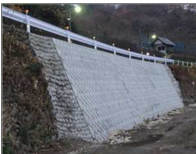
擁壁補強工（道路流失対策）
