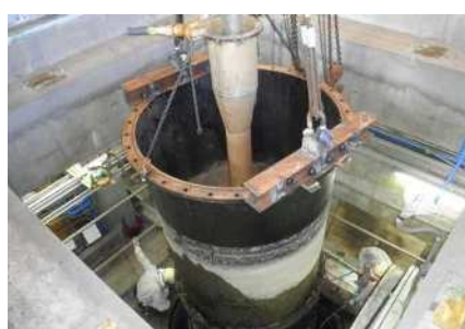
排水機場点検
