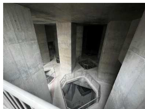
城北中央公園調節池整備状況
