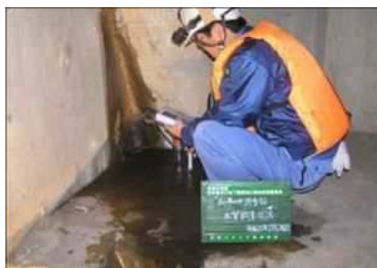
土木躯体点検
