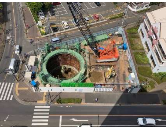
流域下水道雨水幹線の整備 《空堀川上 流雨水幹線（立坑築造工）》
