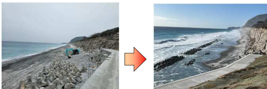
海岸侵食による汀線(海岸線)の後退(新島)
