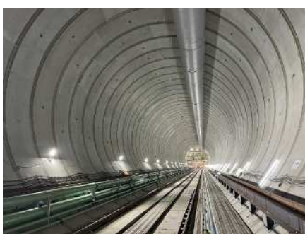
環状七号線地下広域調節池整備状況
