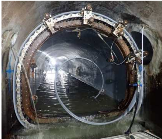
老朽化した下水道管の再構築
