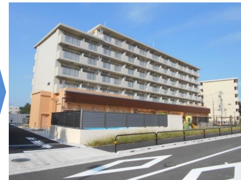
都営扇三丁目第2アパート (平成24年度旧都営本木町第2アパート建替事業)
