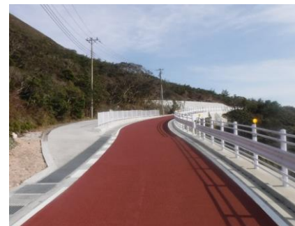
＜神戸山多幸線（鉄砲場2期）の完成状況＞
