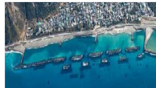
＜新島港海岸の離岸堤＞
